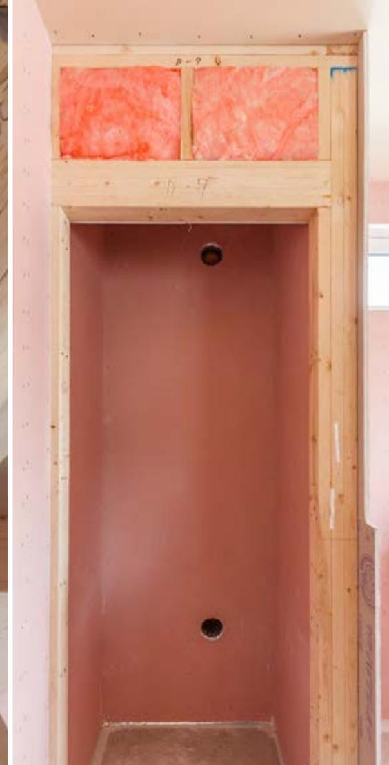
断熱材を隙間なく充填した上から「防湿フィルムシート」を粘着テープで張り込み、気密性を上げ結露を防いでいます。配線穴にも樹脂を充填し、コンセント部分も丹念に断熱します(左)。床組には「Iジョイスト」などを使い耐久性を高めています(中)。高気密・高断熱住宅は寒い部屋がないため、外気を導入して食品を冷やすストッカーを設けていました(右)。
