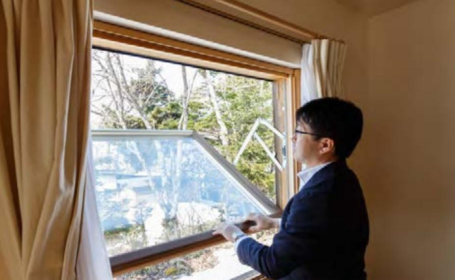
3層の木製サッシは、回転して室内から外側を拭けます。Low-E ガラスによって暖房の熱を外に逃さない効果もあり、夏場は強い日差しを防ぎます。
