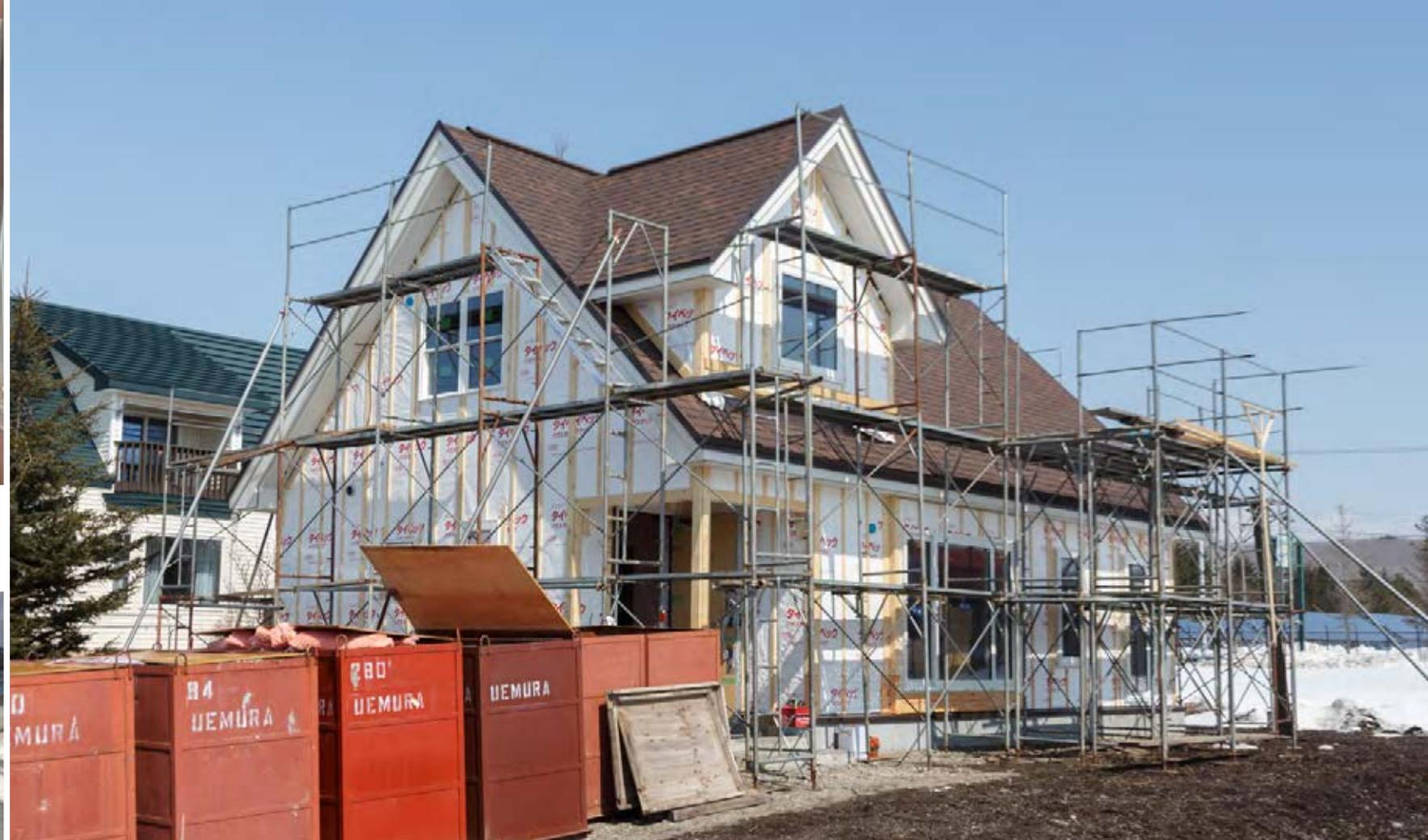
赤坂建設の現場を訪ねました。「北方型住宅」の基準・システムにもとづいて建設中の家で、熱損失係数Q値は1.3程度に設定しているそうです。Q値とは温度差が1℃の時、家全体から1時間に床面積1㎡あたりに逃げ出す熱量のことで、最近ではより正確に特性を把握できる、外皮平均熱貫流率(UA値)を用いることも多くなっています。基礎を凍結しない深さまで掘り下げ、スタイロフォームなどで基礎コンクリートを断熱することで、床下の温度を安定させています。
