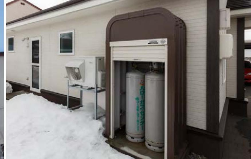
▲ 電気（ヒートポンプ）とガスで暖房・給湯を行うハイブリッドシステムを採用しています。
